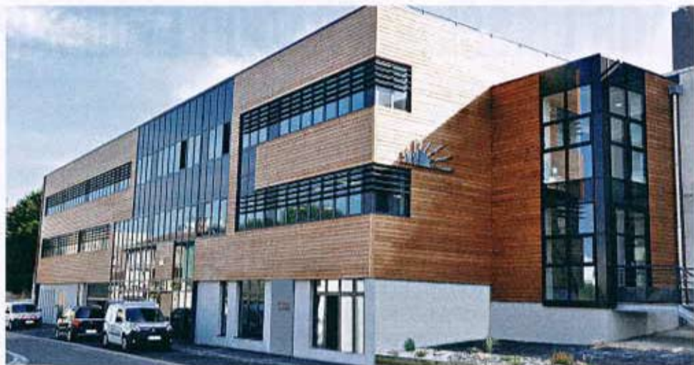
Les nouveaux locaux du SIEL, modèle en matière de performances énergétiques
